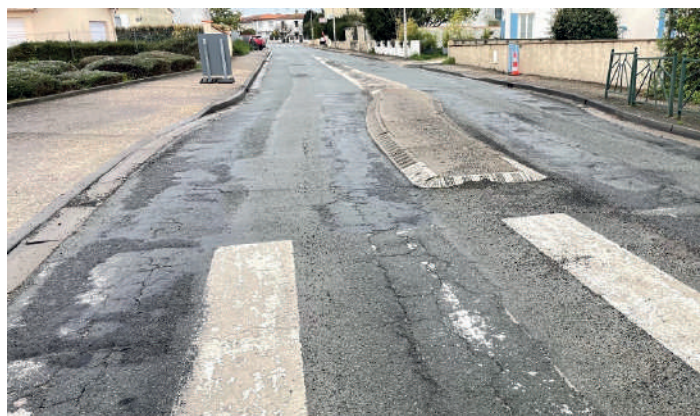
Route Départementale D 140 entrée de commune en venant de Saint-Palais-sur-Mer
