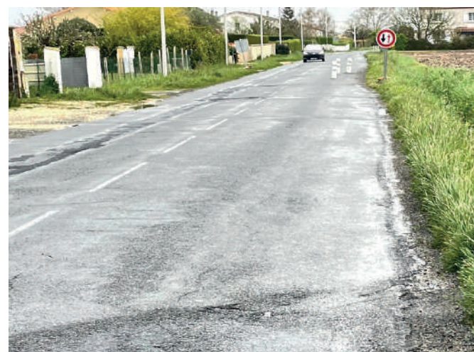
Route Départementale D 733 E entrée de commune en venant de Rochefort
